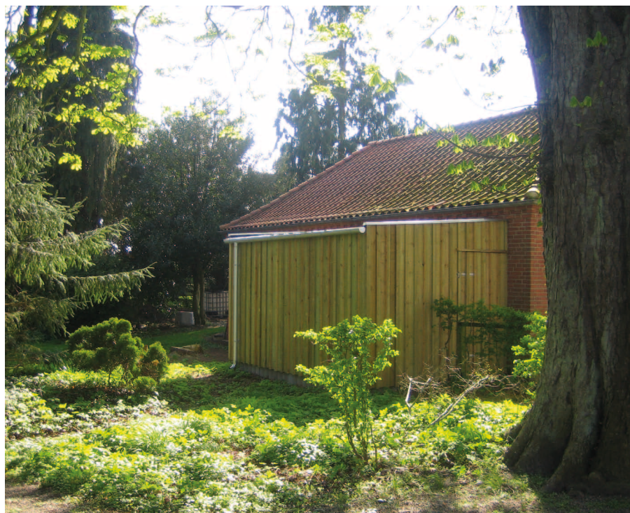
Den nye tilbygning til graverhuset ved Radsted kirke.
