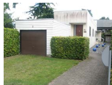
Eksempel på funkisvilla i lokalplanområdet, hvor der skal tages udgangspunkt i bygningens oprindelige arkitektur og ikke lokalplanens bestemmelser.
