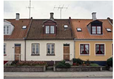
Skorstene er en del af husets samlede fremtoning, hvorfor de skal bevares.
