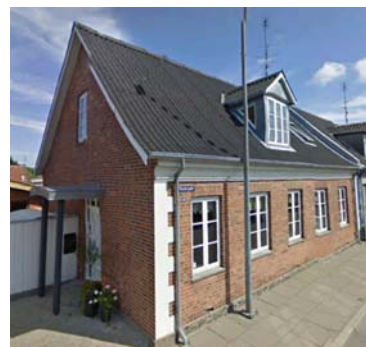
Bevaringsværdige bygninger med blank mur må ikke pudses.
