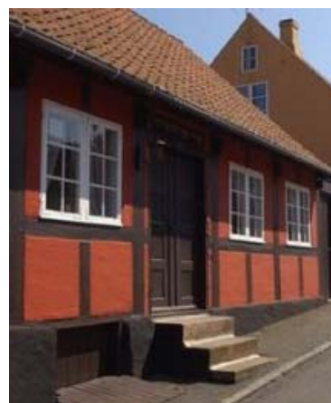
Byhus hvor hoveddøren er holdt i en mørkere nuance end facaden.
